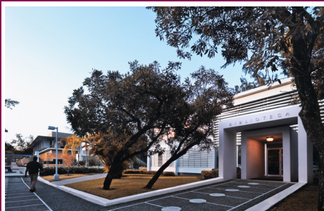
Edificio anexo (Antigua Biblioteca) (1985)
